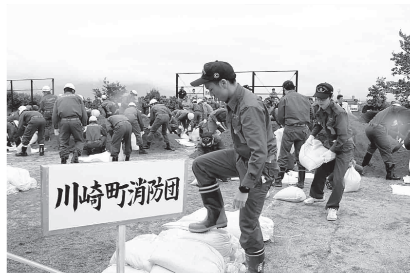
▲素早く丁寧に積み上げられる土のう
