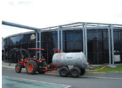
液肥貯留タンク
